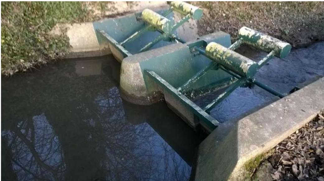
**Figure 1.3 : Photographie de la vanne à l'entrée du canal de décharge**
